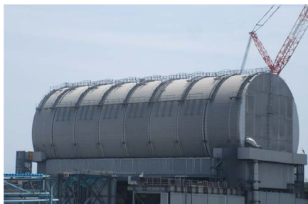
● 現在の3号機原子炉建屋上部（2021年12月）
