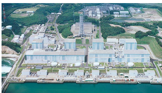
● 福島第2原子力発電所の全景（震災前）
