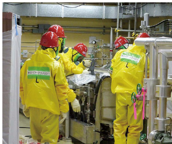
● 福島第2原子力発電所1号炉廃炉作業における除染作業（2021年7月6日）
