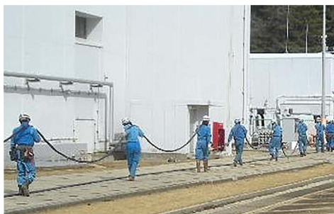
● 震災直後の福島第2での仮設電源ケーブル敷設（2011年3月13日）
