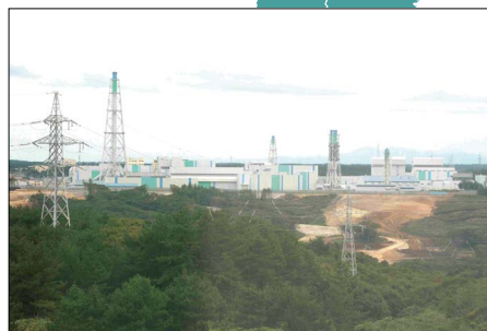
● 稼働に向け準備が進む再処理工場
