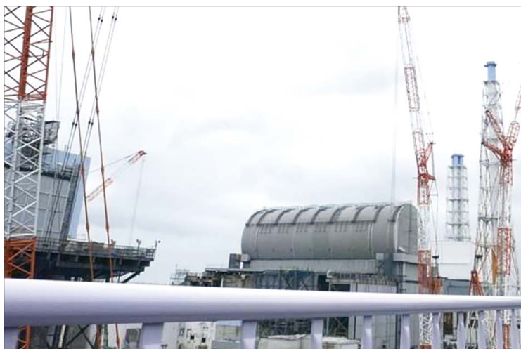
● 水素爆発を起こした3号機には放射性物質の飛散を防ぐドーム型屋根力バーが設置されている。廃炉に向けさまざまな挑戦が続く
