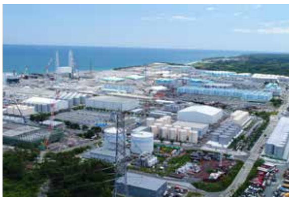
処理水の保管タンクが並ぶ福島第一原発
